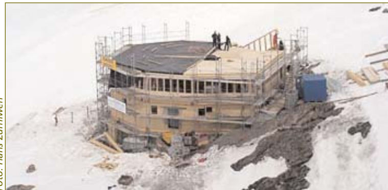
oben links: Prof. Dr. Lino Guzzella oben rechts: Auf 2883 m ü. Meer entsteht ein wegweisendes Projekt im hochalpinen Bauen: Die Neue Monte Rosa-Hütte mit Blick auf das Matterhorn. unten: Dank dem Fleiss der Holzbauer und gutem Wetter stehen nach zwei Wochen Bauzeit bereits zwei Stockwerke der Hütte.
