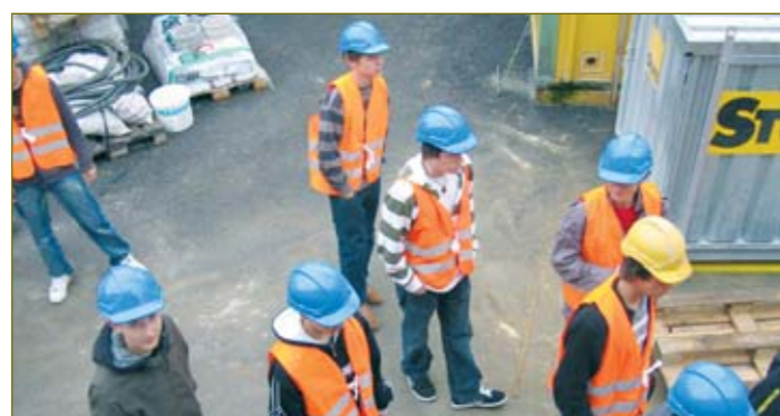
oben: Workshopleiter Beat Michel (Robotik) mit Schülern unten: Baustellenbesuch während der Technikwoche
