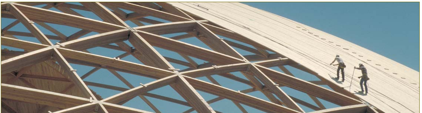
In Deutschland fehlt mehr als ein kompletter Ingenieurjahrgang.
