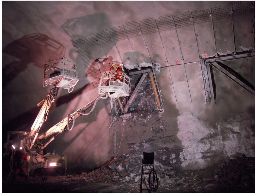
Abbildung 1: Felssicherungsarbeiten
